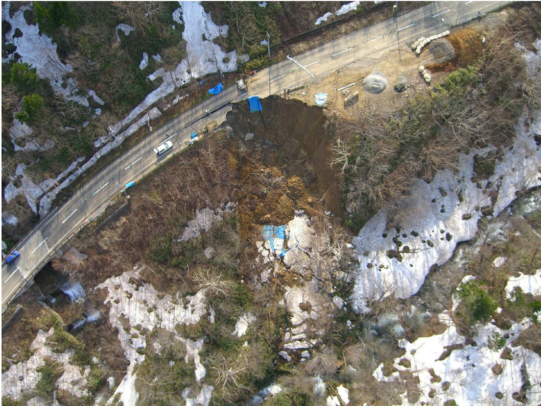
被災全景(上空写真：5月5日撮影)
